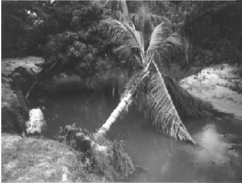
Foto 01 – Processo erosivo na margem direita do Rio paciência
